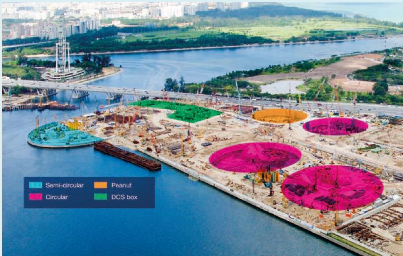
تصویر هوایی از محل احداث پروژه و موقعیت Cofferdams
