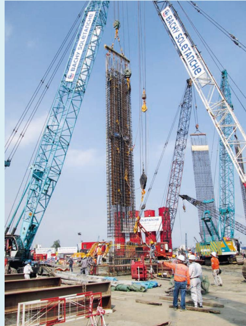
آرماتورگذاری و اجرای شمع‌ها
